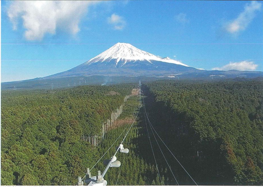
送電鉄塔と送電線
